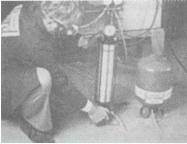
การเติมสารทำความเย็นด้วยกระบอกเติม
