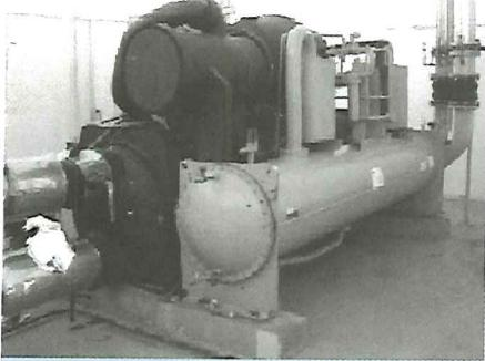
รูปที่ 2 เครื่องทำน้ำเย็นที่ใช้สาร Non-CFC เป็นสารทำความเย็นในระบบปรับอากาศ
