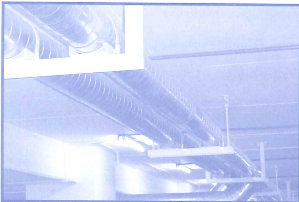
รูปที่ 5 การติดตั้งท่อที่หน้างานที่เสร็จสมบูรณ์แล้ว
