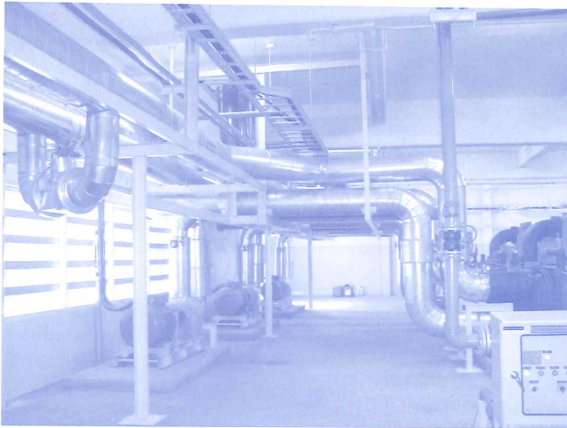
รูปที่ 8 ห้องเครื่องที่ใช้ระบบท่อหุ้มฉนวนสำเร็จรูปเมื่อติดตั้งเสร็จสมบูรณ์แล้ว
