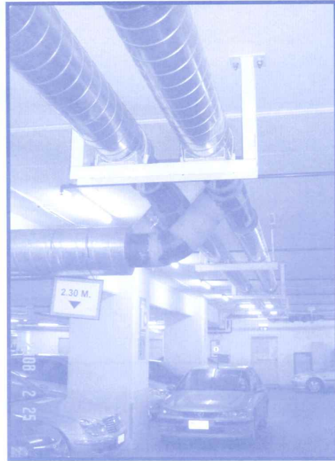
รูปที่ 4 การติดตั้งท่อที่หน้างาน
