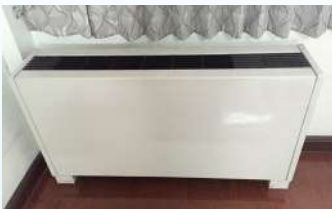
Fan Coil Unit แบบ ตั้งพื้นเครื่อง เดิม อายุ 30 ปี ทนทานมากครับ
