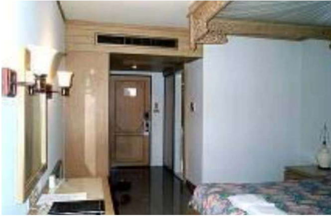
รูปที่ 1 ระบบปรับอากาศช่วยอำนวยความสะดวกให้แก่มนุษย์ในแง่การควบคุมอุณหภูมิให้พอเหมาะต่อความต้องการ
