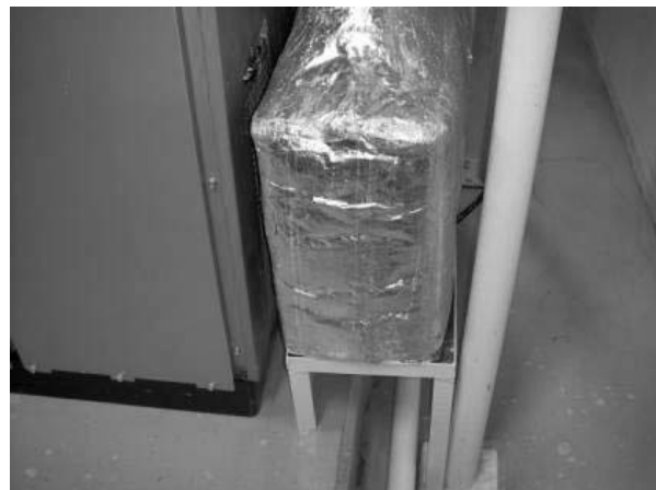
รูปที่ 1. ติดตั้งท่อลมเพื่อลดอุณหภูมิอากาศเข้าเครื่องอัดอากาศ
