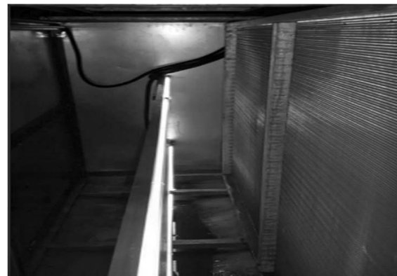
รูปที่ 6 รูปการติดตั้งระบบยูวีในแนวนอน
