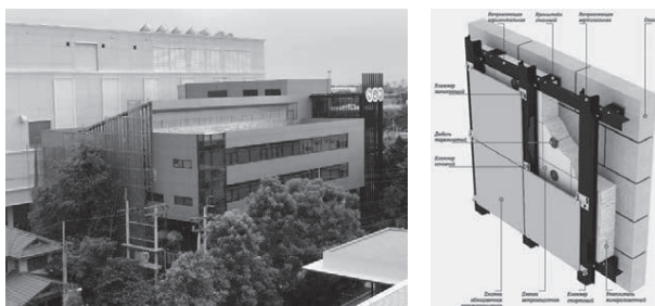
รูปที่ 5: แสดงอาคารที่มีการปรับปรุงเพิ่มฉนวนให้กับผนัง
