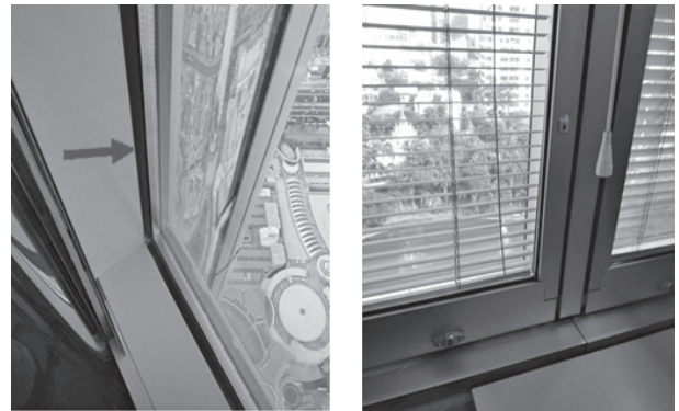
รูปที่ 6: แสดงกระจกที่มี Thermal breaker (ซ้าย) และกระจกแบบ Natural air flow (ขวา)
