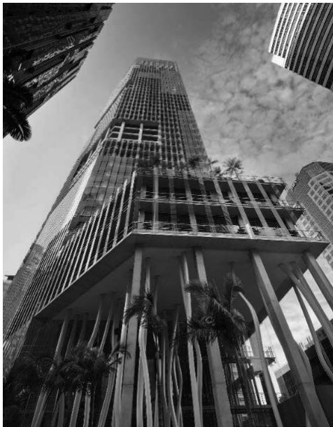
รูปที่ 3 อาคาร Capitagreen ใช้ Supercrete เพื่อลดการใช้วัสดุ
