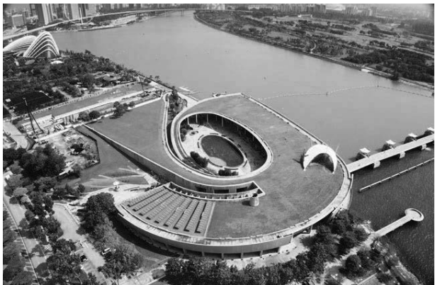
รูปที่ 4 อาคาร Marina Barrage ได้ Green Mark Platinum ประเภท Infrastructure
