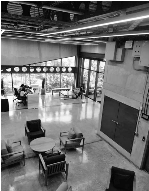
ภาพที่ 7 ตัวอย่างสถานที่ที่ใช้งานระบบปรับอากาศแบบแผ่รังสี
