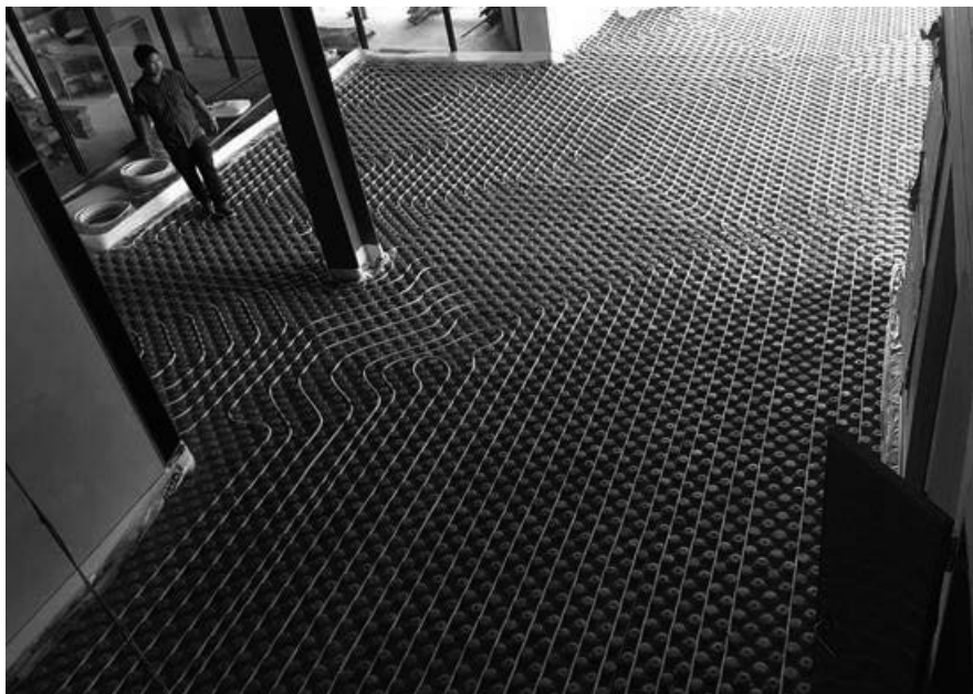
ภาพที่ 6 การติดตั้งระบบปรับอากาศแบบแผ่รังสี
