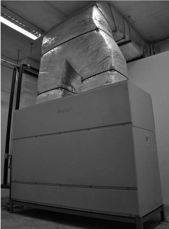
ภาพที่ 4 เครื่องปรับอากาศแบบระบบกลาง (a central system)
