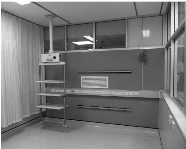
รูปแสดงตำแหน่งหน้ากากระบายอากาศที่หัวเตียงผู้ป่วย
