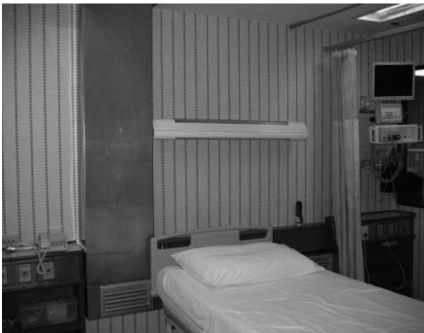
รูปแสดงตำแหน่งหน้ากากระบายอากาศที่หัวเตียงผู้ป่วย
