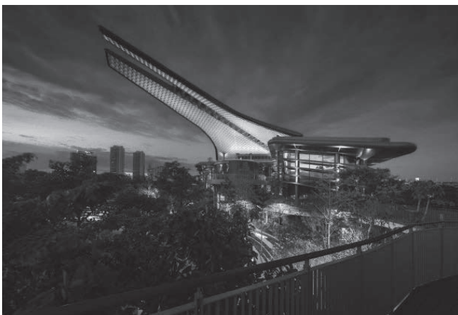
รูปที่ 6 ตัวอย่างการออกแบบอาคารเพื่อให้อาคารทำหน้าที่เป็นปล่องระบายอากาศด้วยหลักการ Stack Ventilation
