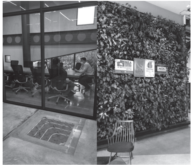
รูปที่ 7 ตัวอย่างของ Radiant floor cooling และ Green wall cooling ที่อาคาร อีอีซี
