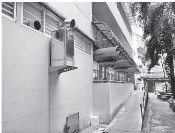
รูปที่ 10 ช่องหน้ากากระบายอากาศ และเครื่องดูดกรองอากาศประสิทธิภาพสูง สำหรับถังขยะติดเชื้อหอผู้ป่วย COVID-19 กุมารเวชกรรม 1 โรงพยาบาลชลบุรี
