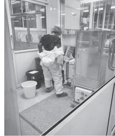
รูปที่ 8 ห้องปรับความดัน และถอดชุด PPE มีกระจก เครื่องดูดกรองอากาศ HEPA fan filter unit หอผู้ป่วยกุมาร 1 โรงพยาบาลชลบุรี
