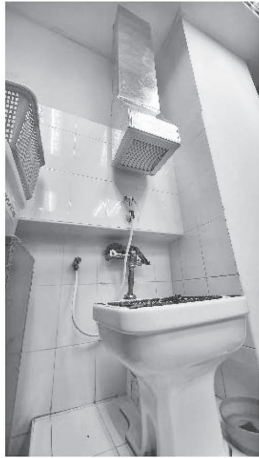
รูปที่ 9 ช่องหน้ากากระบายอากาศเหนือโถสิ่งปฏิกูล โรงพยาบาลชลบุรี และห้องน้ำผู้ป่วย โรงพยาบาลพุทธโสธร
