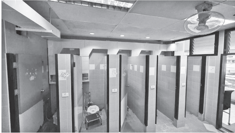
รูปที่ 9 ช่องหน้ากากระบายอากาศเหนือโถสิ่งปฏิกูล โรงพยาบาลชลบุรี และห้องน้ำผู้ป่วย โรงพยาบาลพุทธโสธร
