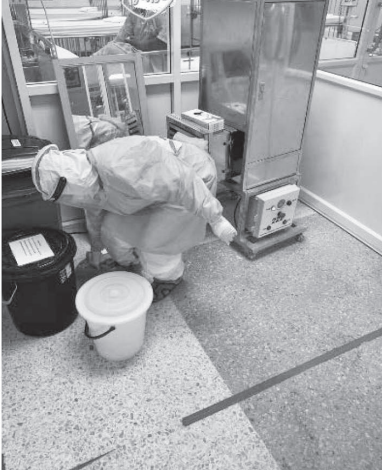
รูปที่ 8 ห้องปรับความดัน และถอดชุด PPE มีกระจก เครื่องดูดกรองอากาศ HEPA fan filter unit หอผู้ป่วยกุมาร 1 โรงพยาบาลชลบุรี
