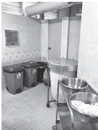
รูปที่ 10 ช่องหน้ากากระบายอากาศ และเครื่องดูดกรองอากาศประสิทธิภาพสูง สำหรับถังขยะติดเชื้อหอผู้ป่วย COVID-19 กุมารเวชกรรม 1 โรงพยาบาลชลบุรี
