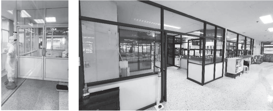
รูปที่ 6 ห้องปรับความดันในเส้นทางเข้าสู่หอผู้ป่วย COVID-19 โรงพยาบาลชลบุรี และ โรงพยาบาลพุทธโสธร
