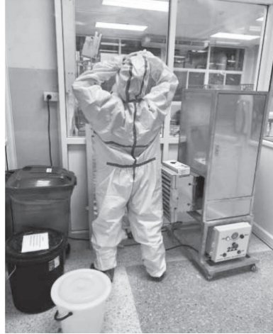
รูปที่ 8 ห้องปรับความดัน และถอดชุด PPE มีกระจก เครื่องดูดกรองอากาศ HEPA fan filter unit หอผู้ป่วยกุมาร 1 โรงพยาบาลชลบุรี
