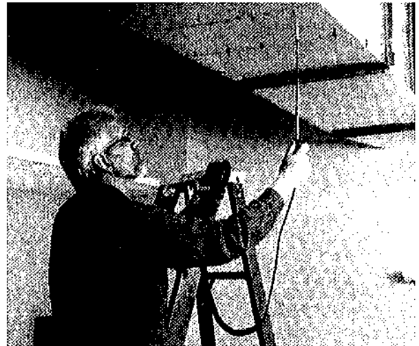
ภาพแสดงการวัดความเร็วลมในท่อลมโดยใช้ Hot Wire Anemometer
