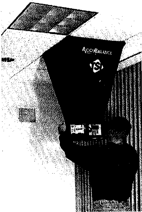
ภาพแสดงการใช้ปล่องวัดปริมาณลม (Air Capture Hood)
